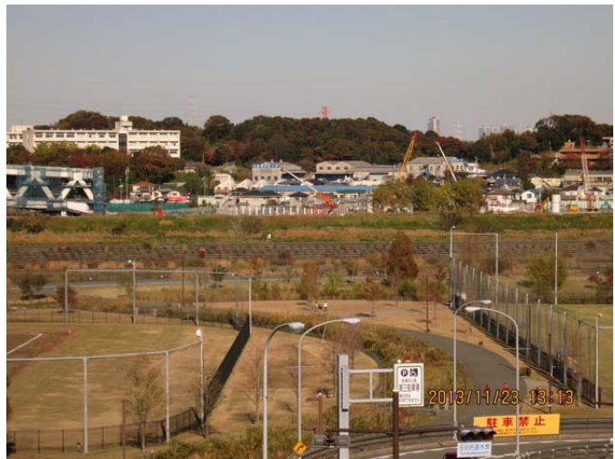
↑ 画像中央を横断するコンクリート部分が越流堤
